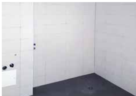
SANITÄRBEREICH IM AUSBAU
