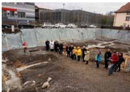
GRUNDSTEINLEGUNG IM JANUAR 2020
