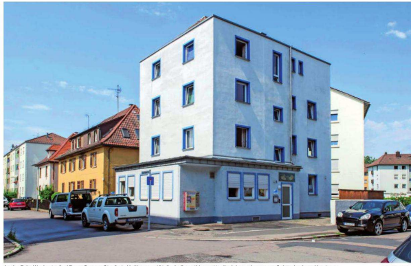
An der Ecke Wackstraße/ Franz-Renner-Straße in Heilbronn reißt die Aufbauhilfe zwei in die Jahre gekommene Gebäude ab und baut neu.
