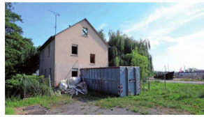
Wiel Obdachlose im kommenden Winter in einem Gebäude in der Neckarhalde übernachten können, steht dem Abriss am Lauerweg nichts mehr im Weg. Foto: wege
