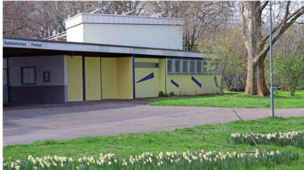
Der gelbe Gebäudeteil des Freibades Neckarhalde wird zum neuen Erfrischungsschutz der Aufbaugilde. Der Umbau ist im Herbst vorgesehen.
