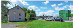
Das Schleusenwärterhaus wird abgerissen. Es soll ein Platz entstehen, der die historische Bedeutung dieses Ortes am Wilhelmkanal deutlich macht. Foto: Archiv/Berger
